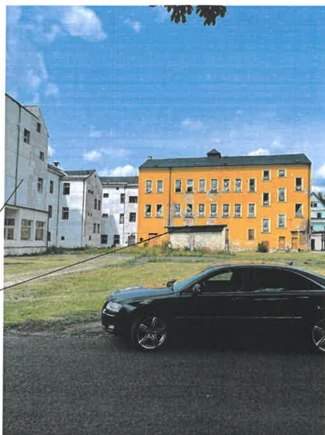
Zadní fasáda domu k demolicí v ulici Havlíčkova
