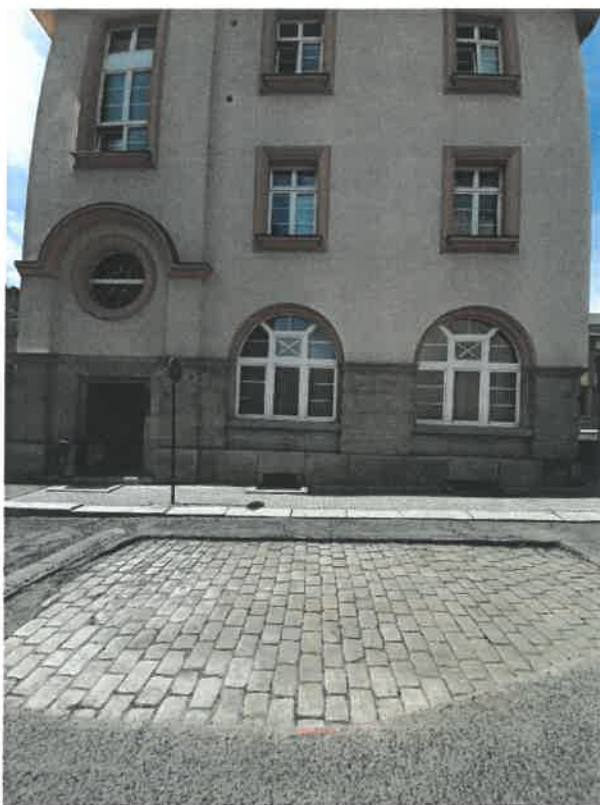
Vedlejší vchod do budovy policie
