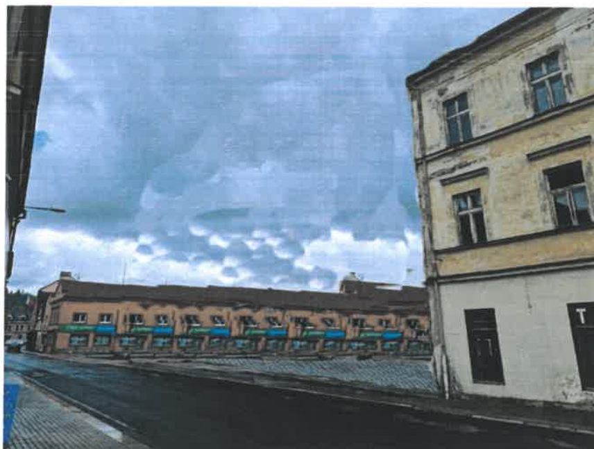
VIZUALIZACE – po demolici. Pohled z ulice Havlíčkova
