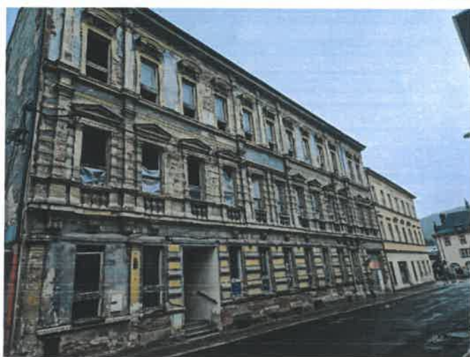
Dům k demolici v ulici Havlíčkova
